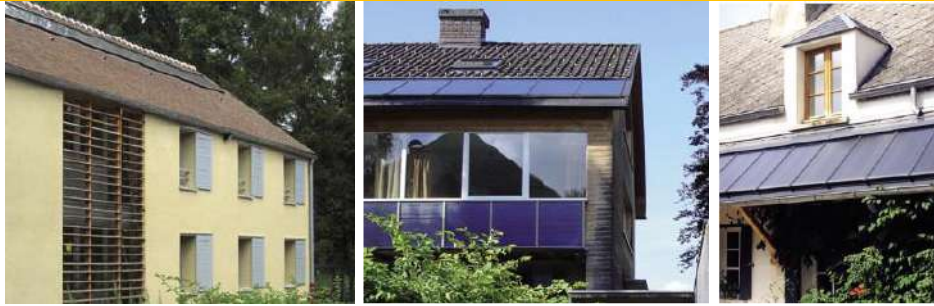
Exemples d'implantation de panneaux solaires
