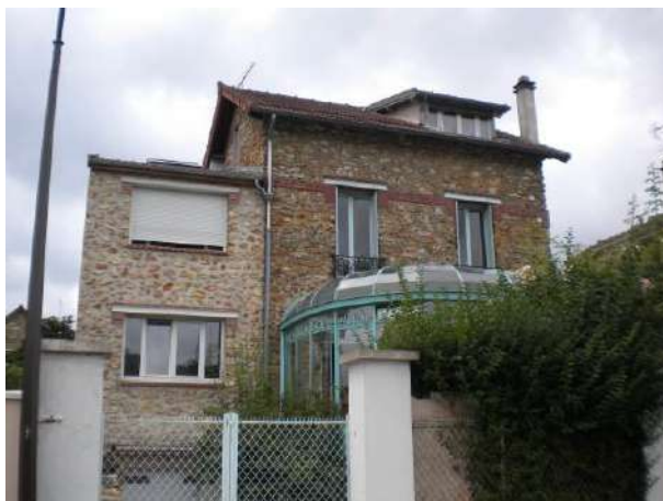
Exemple d'extension reprenant le style de la construction d'origine
